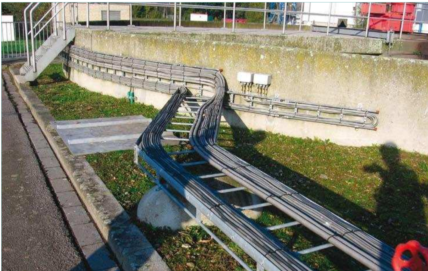
AFB. 2: Onderdeel van de tabellen in de NEN1010 zijn niet alleen de wijze van leggen in bijvoorbeeld de kabelgoot, maar ook omstandigheden, waardoor soms behoorlijk kan worden bespaard op bekabeling.
